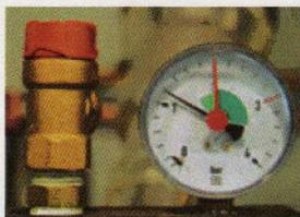
• Vérifiez qu'il y a encore suffisamment d'eau dans votre installation de chauffage: l'aiguille du manomètre doit se trouver entre 1 et 1,5 bar.
